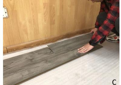
C. Tome otra tabla larga, repita el paso anterior, inserte el lado largo de la tabla en el lado largo de la tabla anterior. A continuación, deslice la plancha hacia la izquierda hasta que el lado corto esté en contacto con el lado corto de la primera plancha colocada.
