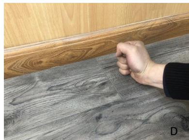
D. Usando el sistema de bloqueo de caída, deje caer el lado corto de la última tabla larga en el lado corto de la primera tabla colocada. Golpee ligeramente la parte superior de la articulación del lado corto con el puño para asegurarla.
