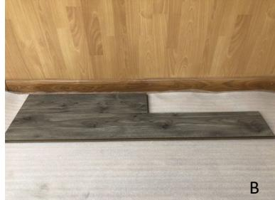
B. La primera fila debe instalarse recta. Comience la instalación de ida y vuelta entre las filas uno y dos solo para las dos primeras filas. Comience con un tablón pequeño colocado cerca de la pared, incline un tablón largo hacia el lado largo del tablón corto y deje caer la lengüeta del tablón largo en el bloqueo. Asegúrate de que no haya huecos.
