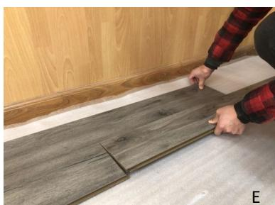
E y F. Terminando las filas 1 y 2: continúe alternando tablones en las filas 1 y 2 para evitar la desalineación. A partir de la fila 3, la instalación no requiere alternar filas. Instale una fila tras otra comenzando con un ángulo en el lado largo, deslizando hasta que los lados cortos estén en contacto y luego bloqueando el lado corto. A medida que avanza, asegúrese de que los lados cortos estén bien bloqueados golpeando con el puño o, si es necesario, con un mazo de goma.
